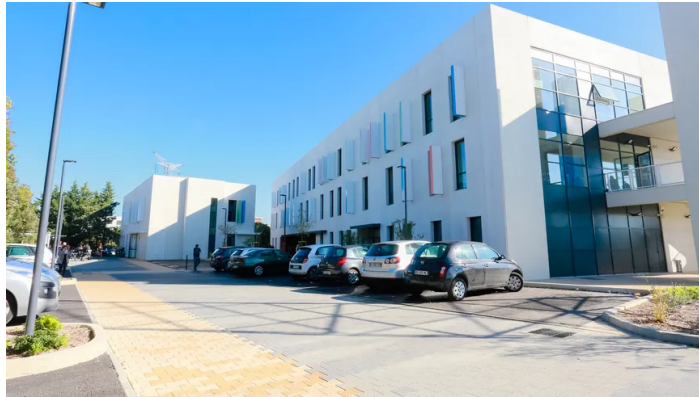
La nouvelle école sera implantée sur le campus du Millénaire à Montpellier - Mandou
